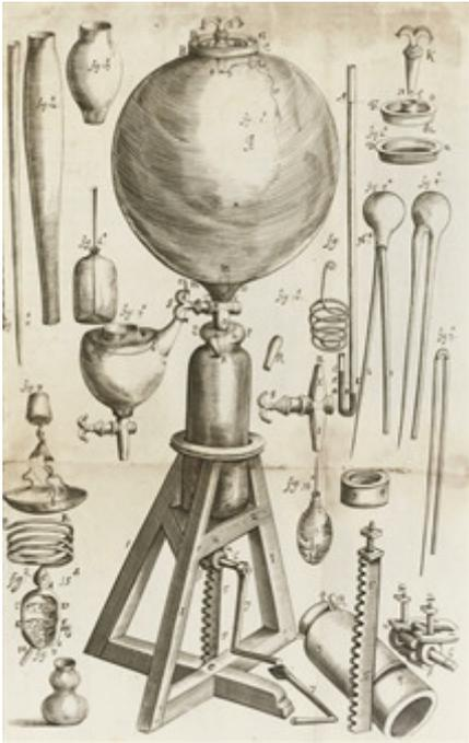
**Figura 14: Bomba de ar de Boyle, projetada e construída por Robert Hooke.**
