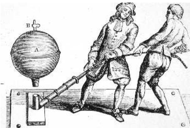
Figura 10: Bomba de Von Guericke sendo utilizada para remoção do ar de uma esfera de cobre.
