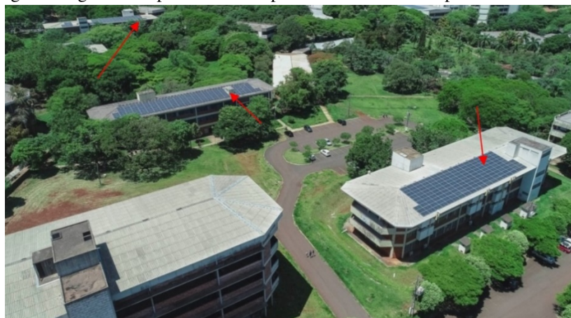
Figura 1 – Imagem fotográfica de prédios do campus sede da UEM com painéis de células fotovoltaicas.
